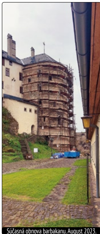
Súčasná obnova barbakanu. August 2023.
